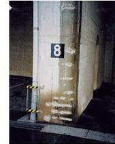
雨水による鉄筋腐食と剥落
